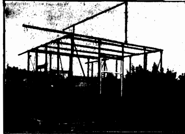
SZKIELET DOMU ZE STALI systemu Inz. Urbana, zmniejszającego koszt budowy o 40 procent.
